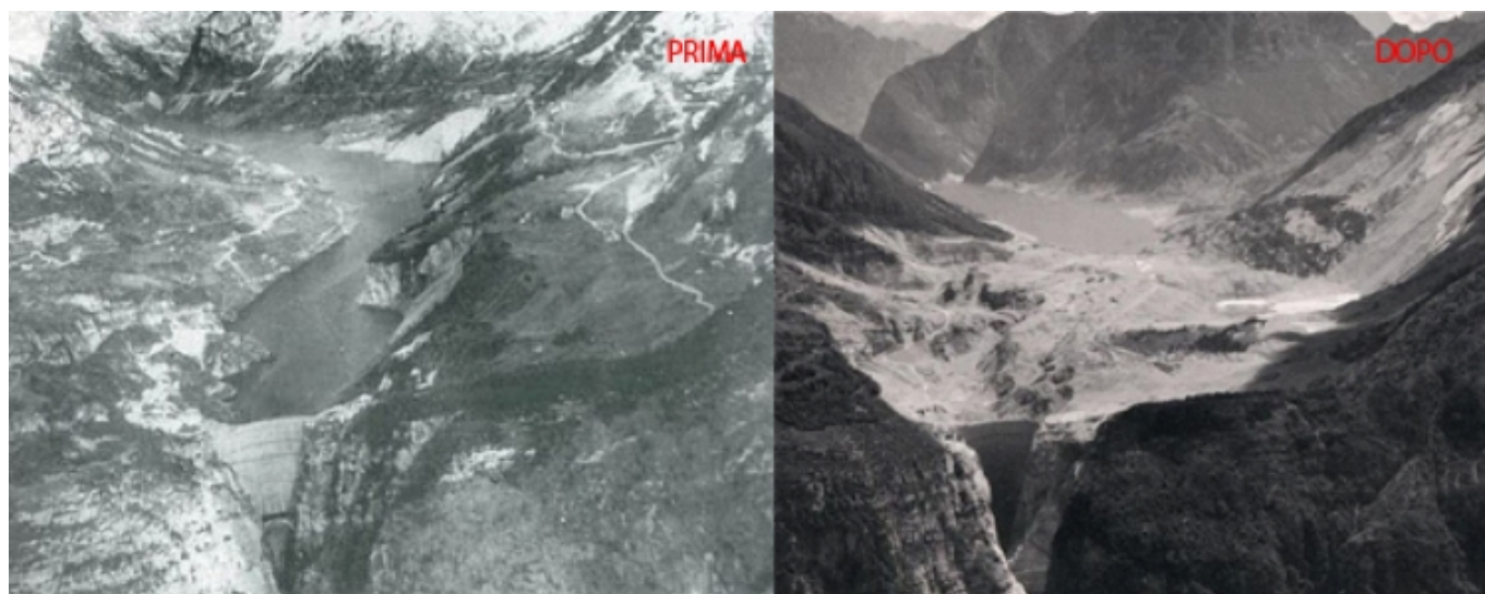
Vajont, prima e dopo la frana
