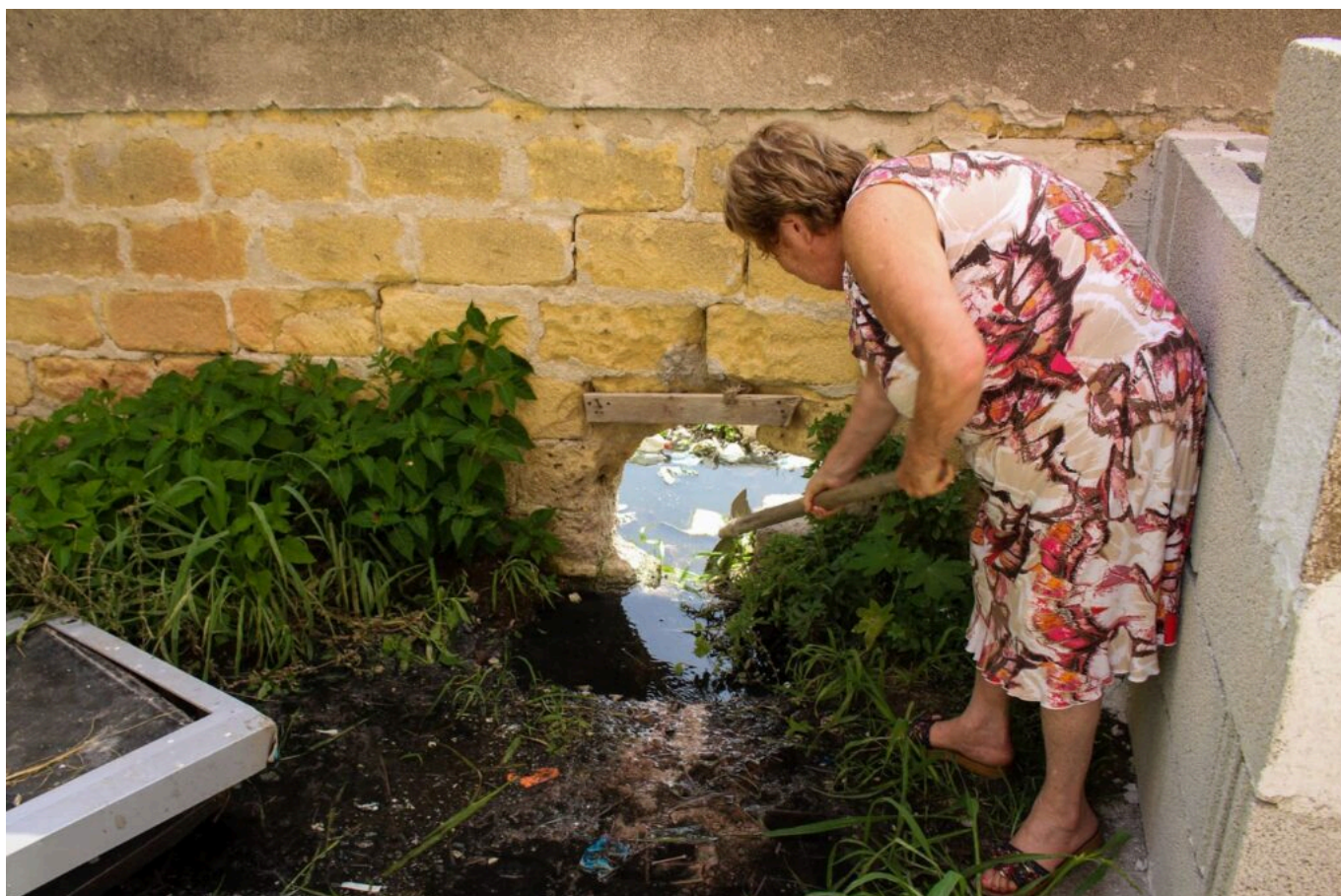
La signora Fina impegnata nei lavori per far defluire le acque reflue
