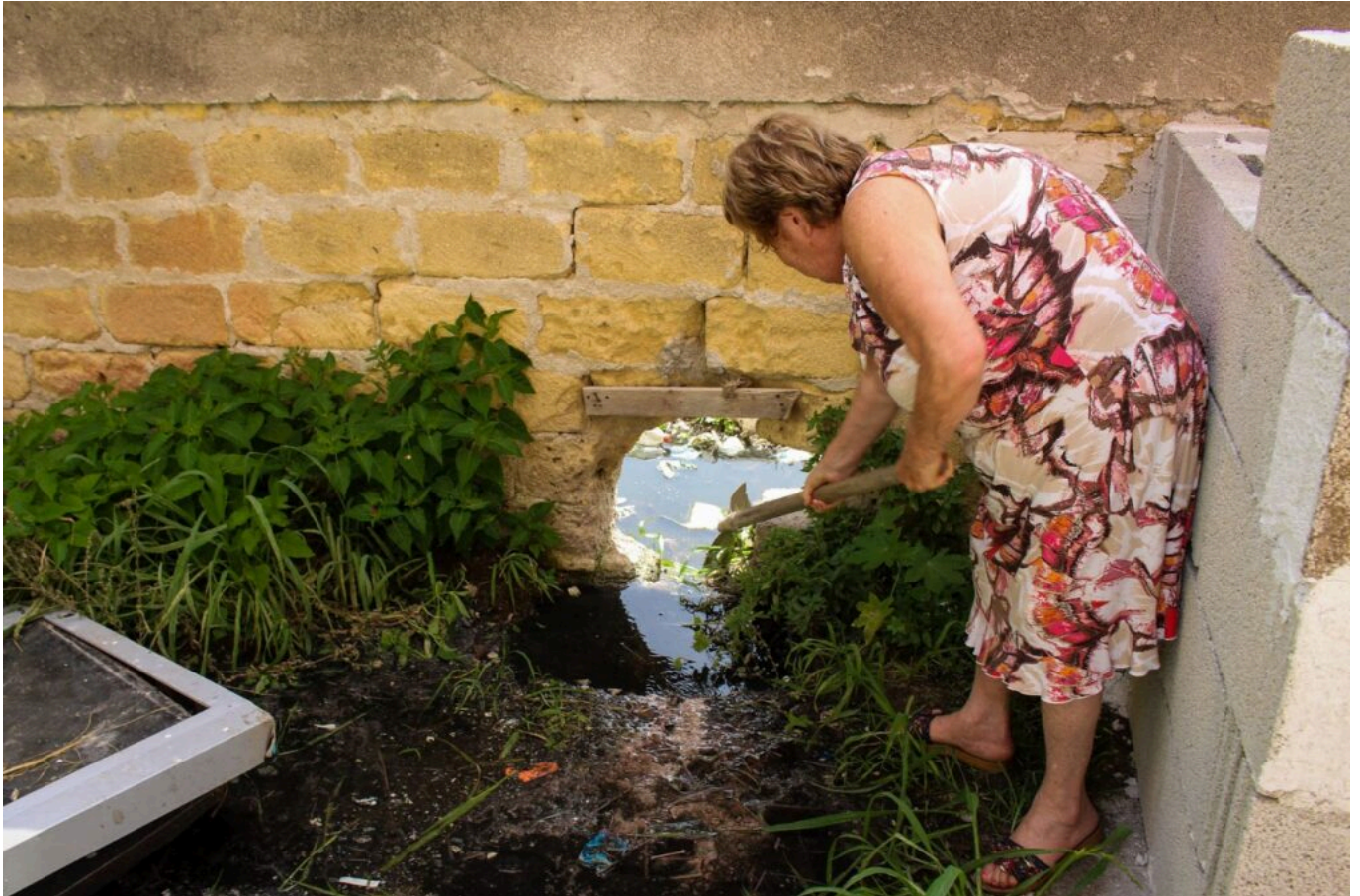
La signora Fina impegnata nei lavori per far defluire le acque reflue
