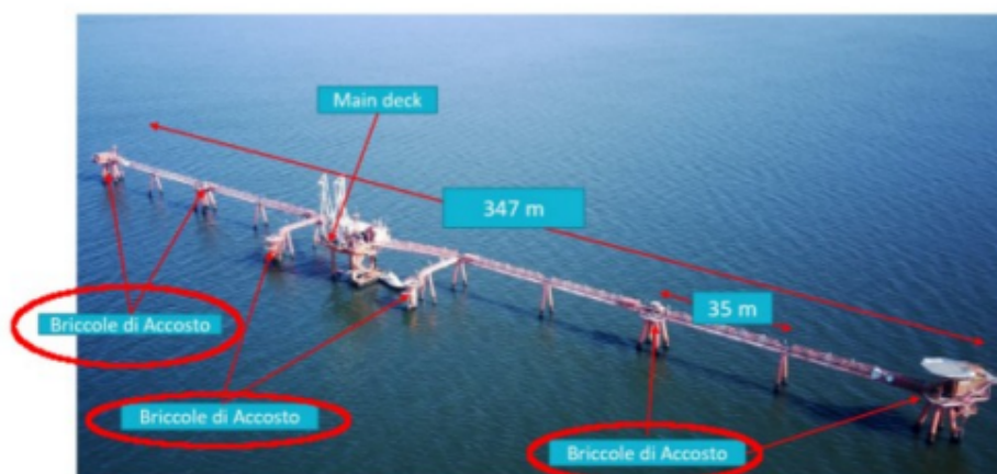
Figura 4-2 – Struttura del Piattaforma offshore PETRA esistente
