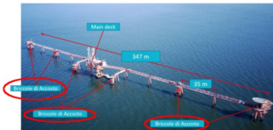
Figura 4-2 – Struttura del Piattaforma offshore PETRA esistente
