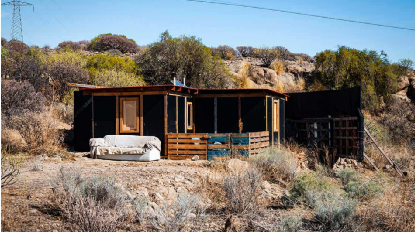
Un appartamento costruito dai volontari interamente con porte riciclate dalla ristrutturazione di un hotel
